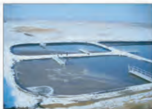
Stocarea dejețiilor Bazine și platforme impermeabile
