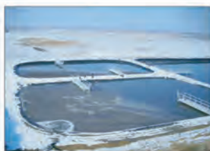
Stocarea dejețiilor Bazine și platforme impermeabile
