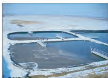
Stocarea dejețiilor Bazine și platforme impermeabile
