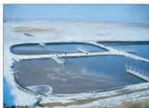
Stocarea deieciilor Bazine și platforme impermeabile
